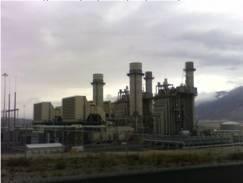
Газова турбіна генератора електроенергії GE серії 480 мегават
