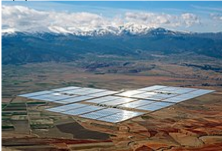
Сонячна електростанція Andasol потужністю 150 МВт - це концентрована сонячна електростанція, розташована в Іспанії.
