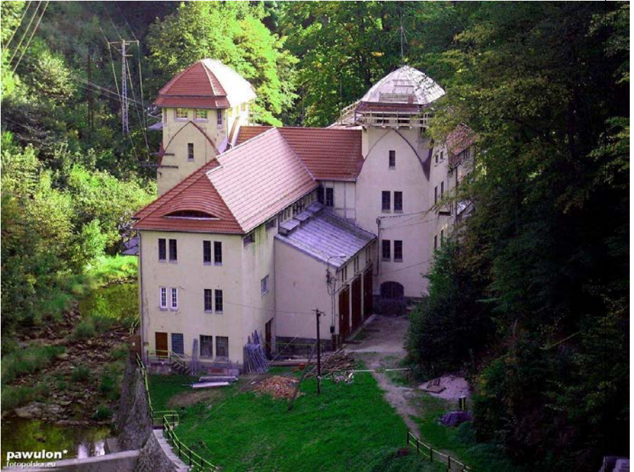
Підстанція у будівлі у формі замку 1910-х років служить розподільним пунктом біля греблі Лесна, однієї з кількох гідроелектростанцій на річці Бобр.
