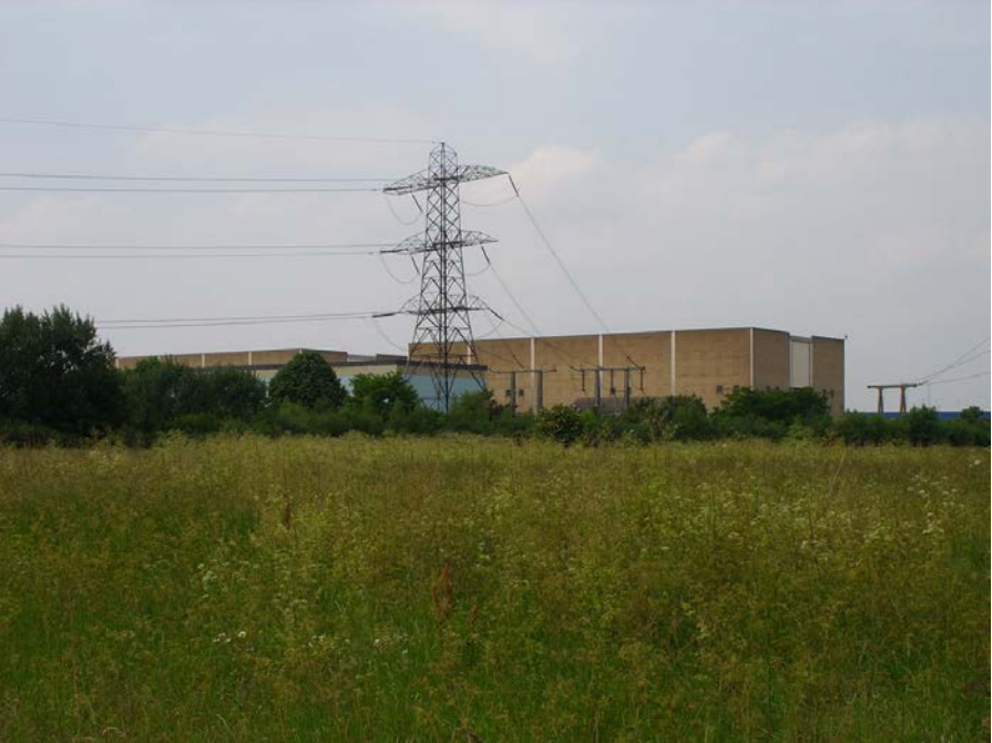
Підстанція "Тоттенхем", розташована в дикому парку на півночі Лондона.
